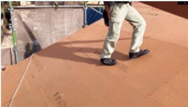
屋根下地用スターウッドの施工テストの様子
